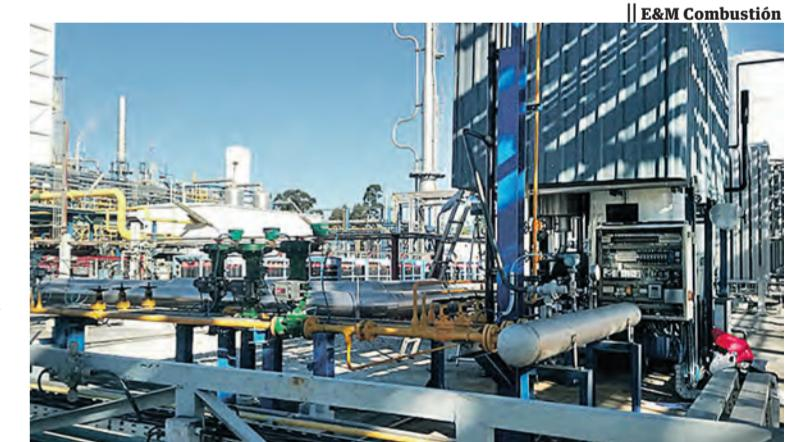
por E&M Combustión para esta planta química corresponde al modelo JBD-3500 GHCo. Los quemadores JBD son equipos duoblock preparados para vencer sobrepresiones de cámara de combustión. Se fabrican en el rango de 1.000 a 85.000 kW y se utilizan con todo tipo de combustibles líquidos y gaseosos. [EE]
